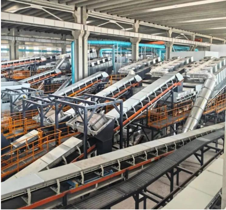
△建筑垃圾资源化产线
